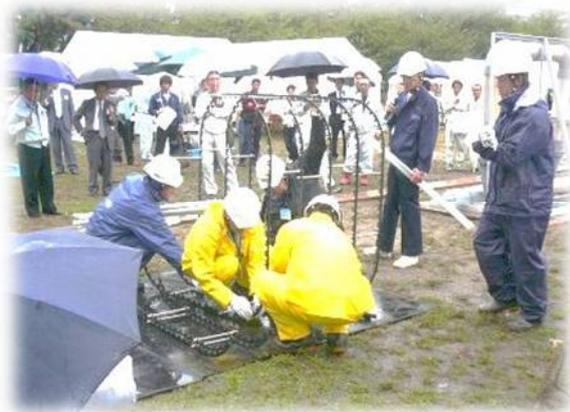
成工法ホースライニング工法の模擬反転を高難度ループ配管(90度ベンド4箇所)を使い反転工法が長尺、複雑な配管に適していることを再確認していただきました。続いての実演はパルテム・フローリング工法の模擬実演で鋼製リングの組立、かん合部材・表面部材の組付を実演、フ
