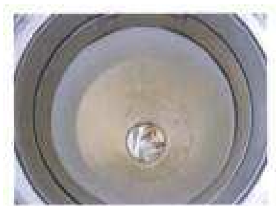
写真 4-4 試験後の内面状況
