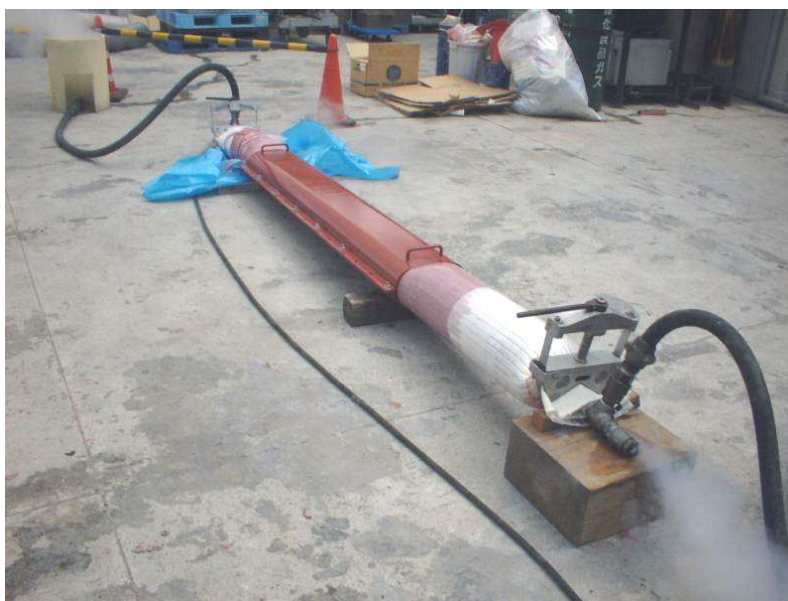
写真 4-2 平板試料作製状況
