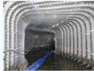
S字屈曲部の鋼製リング施工状況
