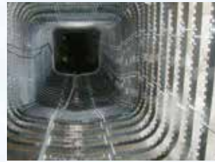
段差部の鋼製リング施工状況
