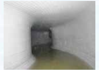
S字屈曲部の更生内面
