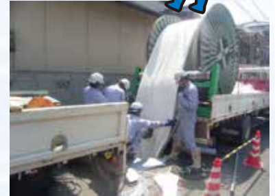
SZライナーをマンホールより 管きよ内に引き込み中
