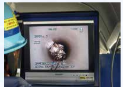
管きよ内から取付管口を穿孔中
